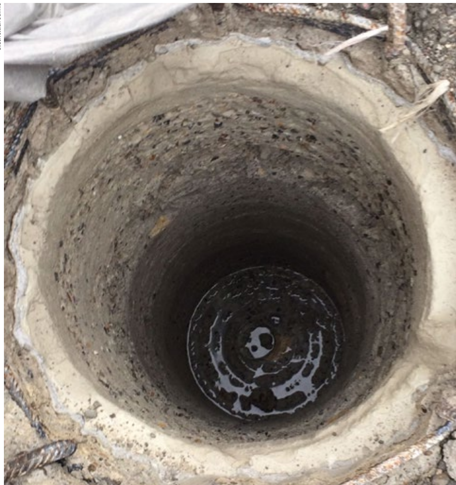
Fremdstoffe und Schmutz im Beton beeinträchtigen die statische Funktion von Pfählen. Mit dem Innenfräser können für Sanierungen Pfähle bis auf eine Tiefe von sechs Metern ausgebohrt werden, sodass ein zweiter Pfahlkorb einbetoniert werden kann.
