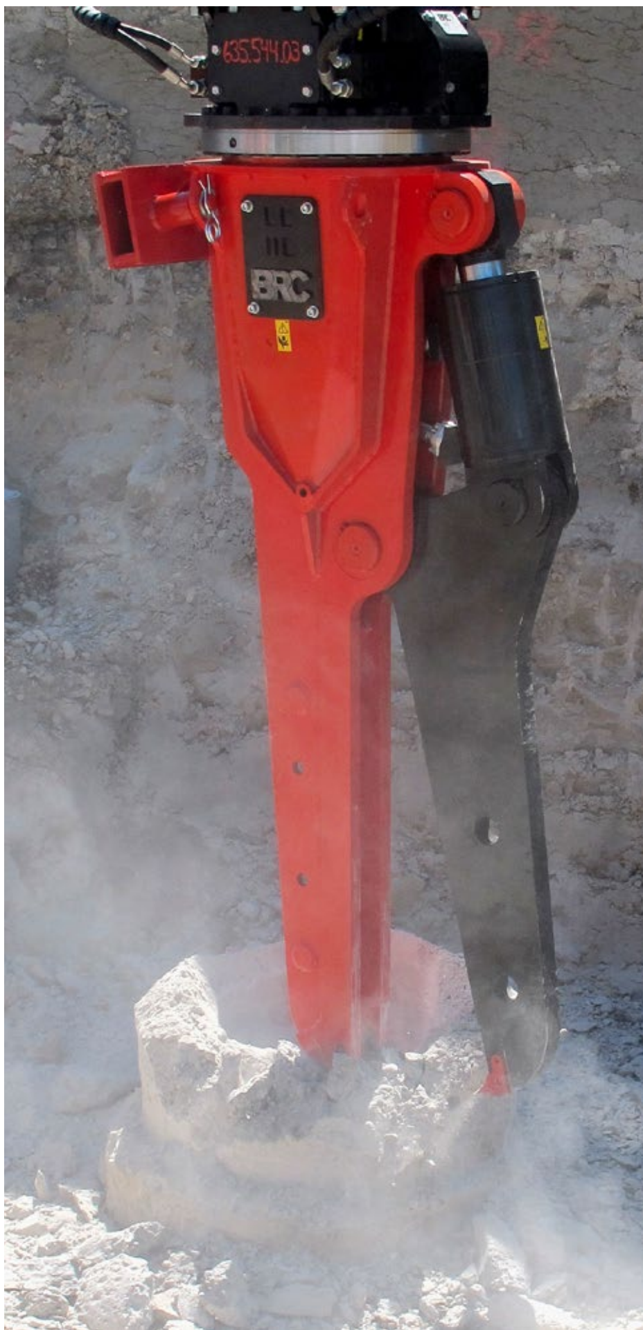
Bohrkopf und Beisser des Brextor-Systems sind 1,8 Meter lang. Damit können Bewehrungen bis auf eine entsprechende Höhe freigelegt werden, damit die Länge der Anschlussarmierungen die Normen der Erdbebensicherheit erfüllt.
