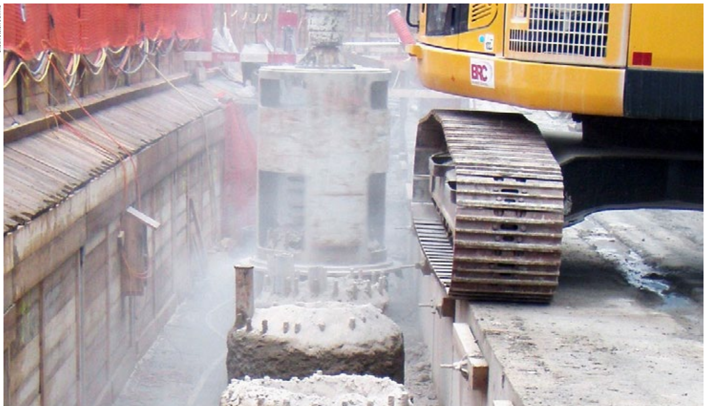
Fräsvorgänge innen wie aussen gleichzeitig auszuführen, gehört zum durchdachten Prinzip des Brextors.
