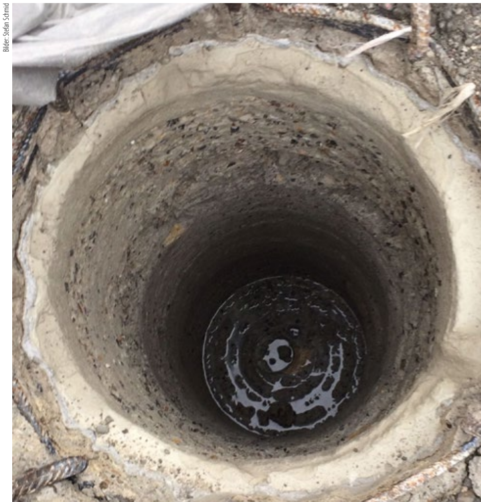
Fremdstoffe und Schmutz im Beton beeinträchtigen die statische Funktion von Pfählen. Mit dem Innenfräser können für Sanierungen Pfähle bis auf eine Tiefe von sechs Metern ausgebohrt werden, sodass ein zweiter Pfahlkorb einbetoniert werden kann.
